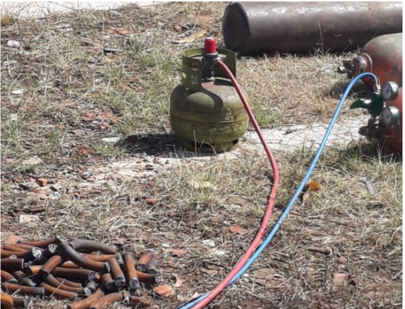
Gas LPG Subsidi 3 Kg yang digunakan sebagai bahan bakar pemotongan besi proyek jalan
